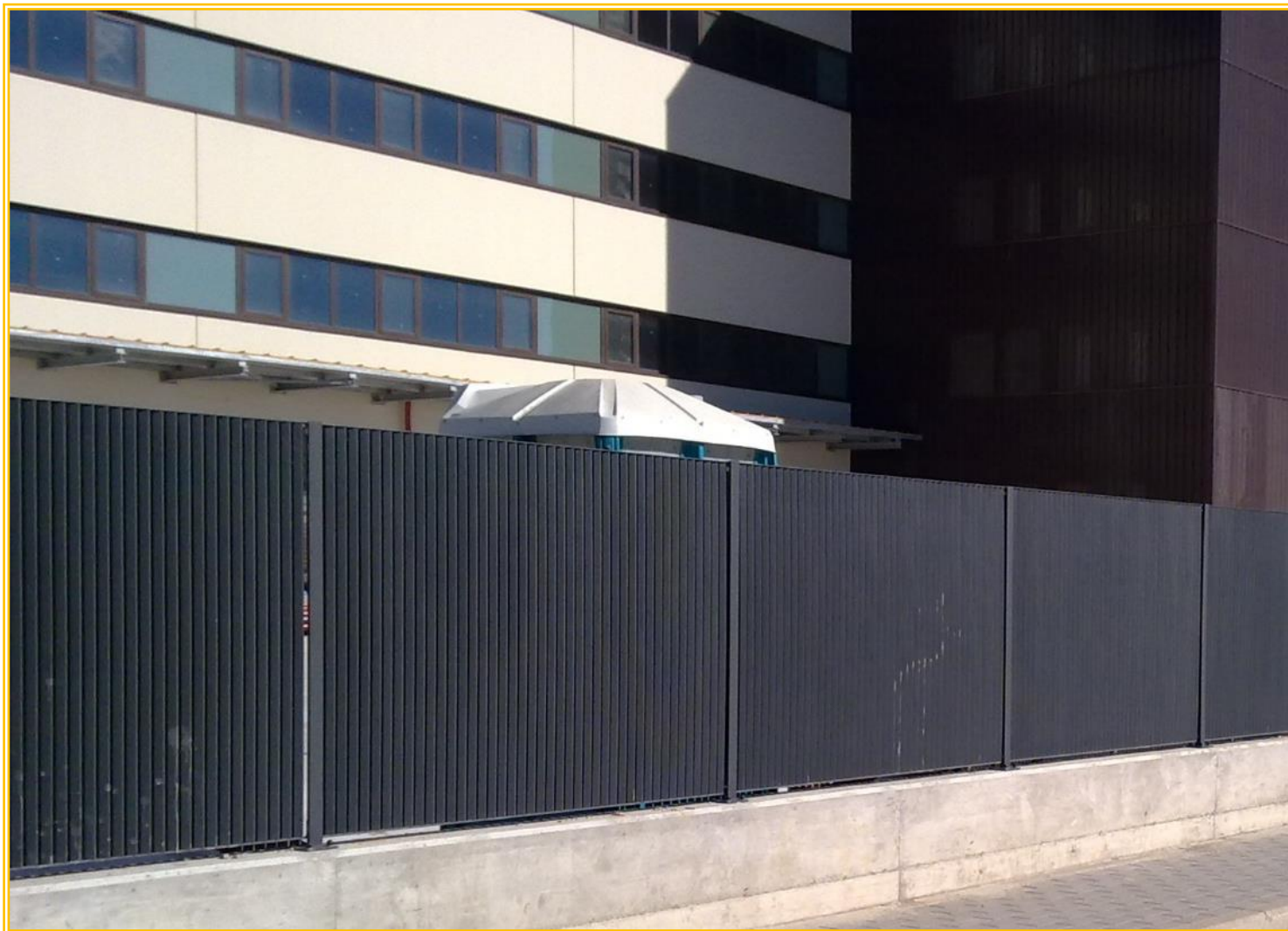
Recinzione modulare in grigliato elettrosaldato con profilo rompivisuale
